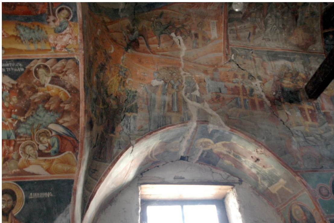
Εικ. 6. Ρηγματώσεις στην θολοδομία.
